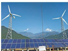
चित्र ९.१६ सिन्धुलीको हरीहरपुरगढीमा अवस्थित २० kW क्षमताका वायु टर्बाइन
